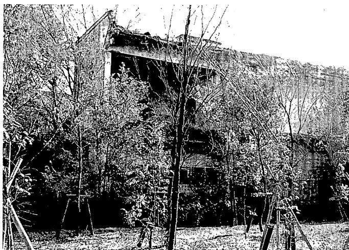
同じく公園遊歩道に近い放置された旧米軍兵舎。多くの落書をみる
