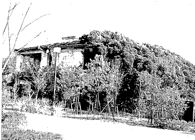
公園遊歩道に最も接近した旧米軍兵舎の残骸、火葬場の中心部分
