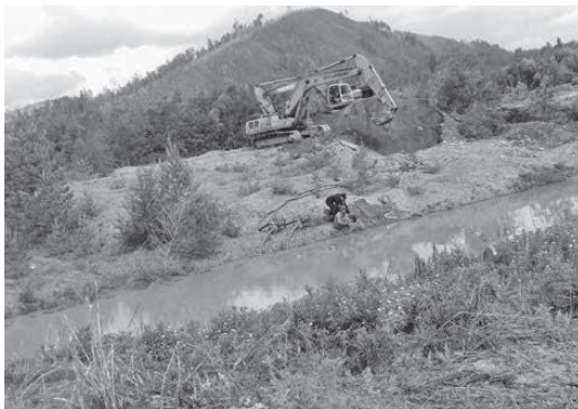
写真2 鉱山の採掘を行う重機
